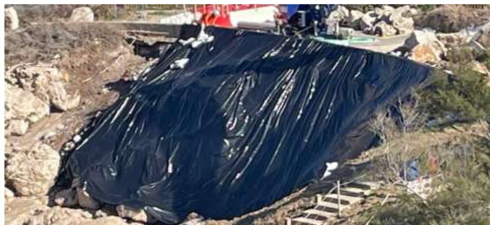
Mise en place de bâches antipoussières dès interruption du chantier
