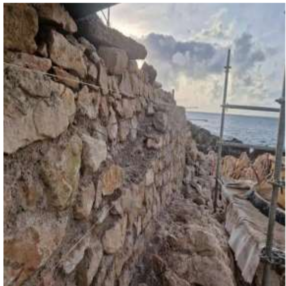
Renforcement de l'ancienne structure
