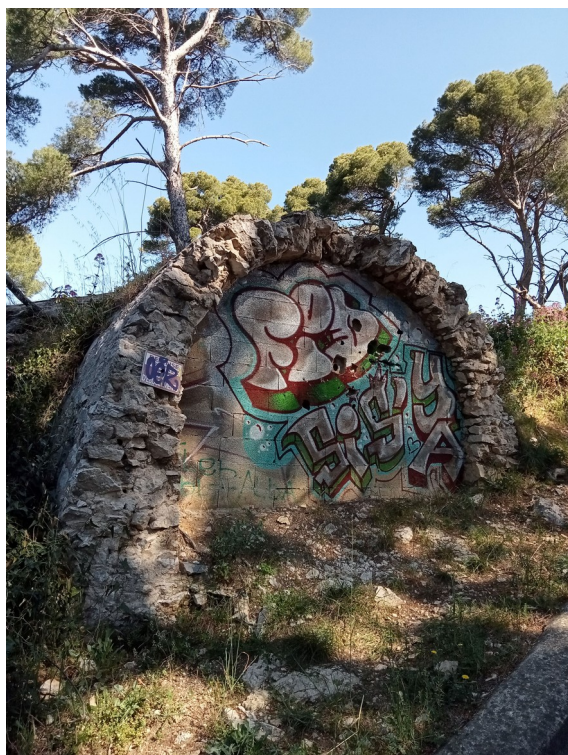
cheminée rampante mise en sécurité
