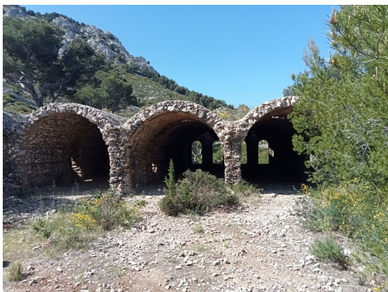
Accès à la zone de condensation des fumées
