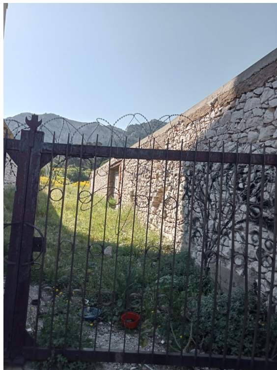
Portail et mur sur la partie Nord de la Friche
