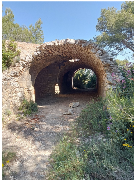
zone de condensation des fumées
