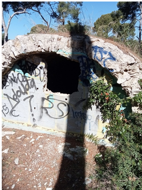
mur de mise en sécurité de la cheminée rampante ayant subi des dégradations
