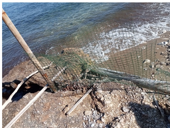
Barrière détruite – accès plage Sud
