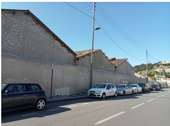
Friche Legré Mante - accès route
